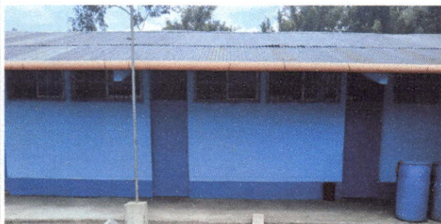
Foto 7: Pintura en muros exteriores e interiores
