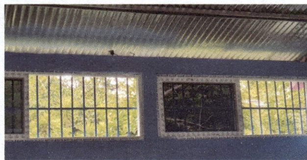
Foto 2 Sustitución de ventanas de madera por ventanas de pvc
