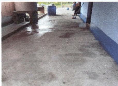
Foto 5 Sustitución de piso de torta de concreto
