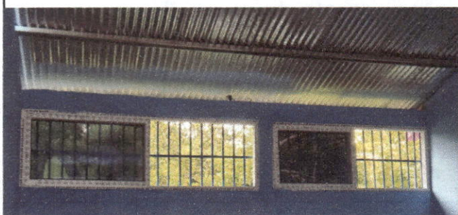
Foto 3 Sustitución de balcones de metal
