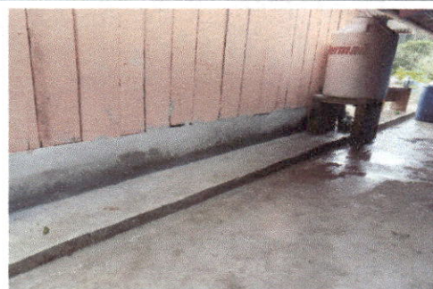
Foto 6 Reparación de cuneta de concreto
