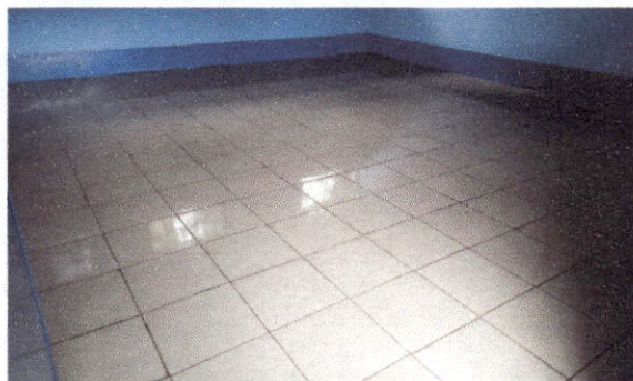
Foto 4 Sustitución de piso de torta de concreto por piso ceramico
