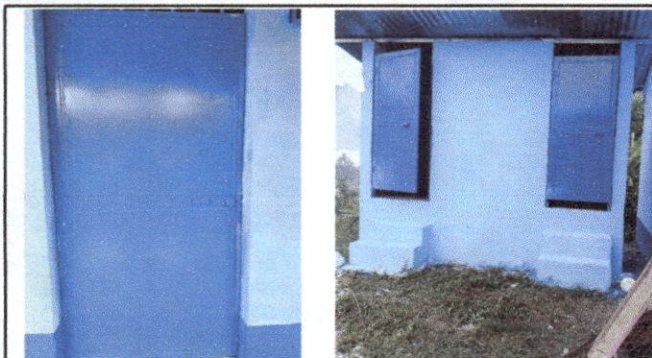
Foto 1: Sustitución de puertas y Sustitución de puerta en servicio sanitario
