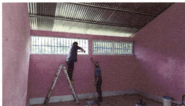
Foto 2 Sustitución de ventanas de madera por ventanas de pvc
