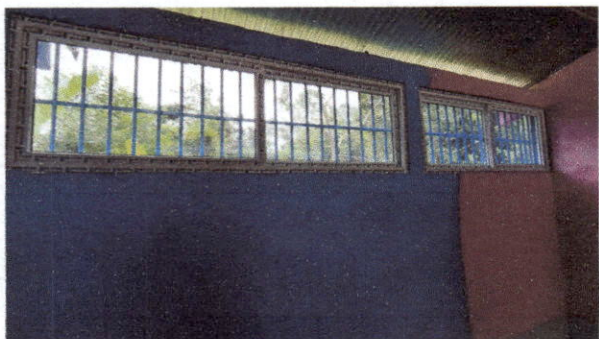
Foto 7: Pintura en muros exteriores e interiores
