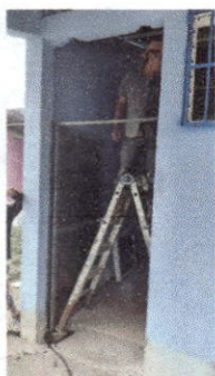
Foto 1: Sustitución de puertas y Sustitución de puerta en servicio sanitario
