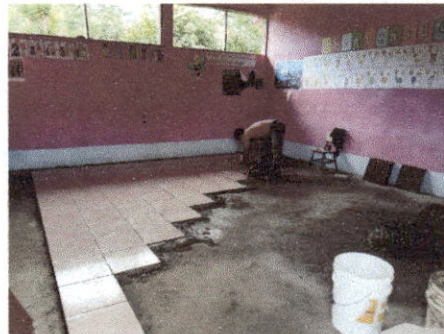
Foto: 4 Sustitución de piso de torta de concreto por piso ceramico
