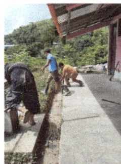
Foto: 6 Reparación de cuneta de concreto
