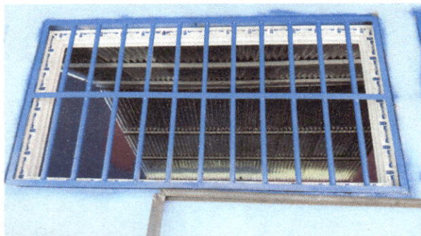
Foto: 3 Sustitución de balcones de metal
