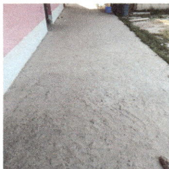
Foto 5: Sustrucción de piso de torta de concreto
