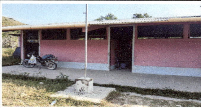
Foto 7: Pintura en muros exteriores e interiores
