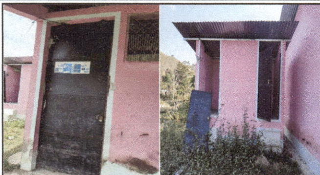
Foto 1: Sustrucción de puertas y Sustrucción de puerta en servicio sanitario
