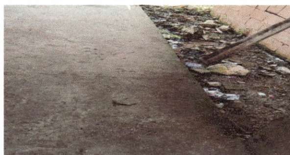
Foto 6: Reparación de cuneta de concreto
