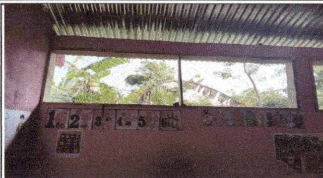
Foto 2: Sustrucción de ventanas de madera por ventanas de pvc
