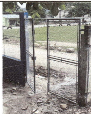
Foto 8: Sustrucción de portón de metal
