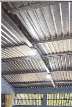
Foto 7: Sustrucción de conducto electrico mas accesorios
