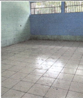
Foto 3: Sustitución de piso
