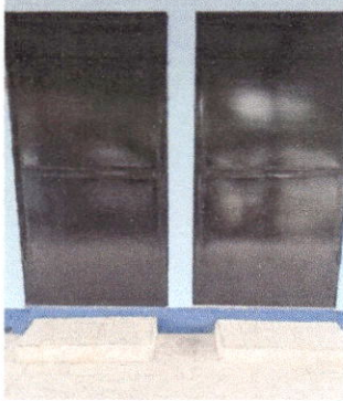
Foto 1: Mantenimiento a puertas de metal
