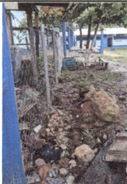
Foto 5: Reparación de tubo hg y malla galvanizada
