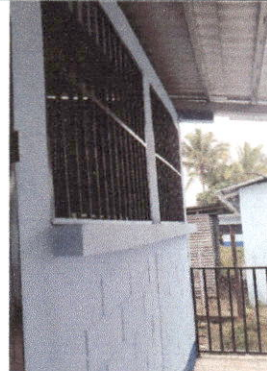
Foto 2: Mantenimiento a balcones de metal
