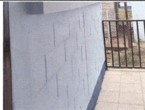
Foto 4: pintura en muros exteriores e interiores
