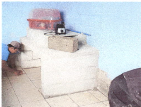
Foto 9: Sustitución de estufa rural
