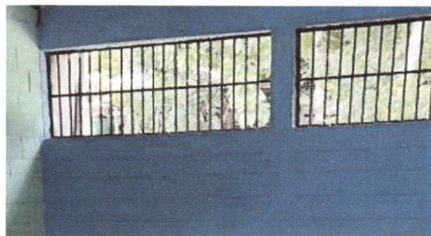
Foto 2: Mantenimiento a balcones de metal
