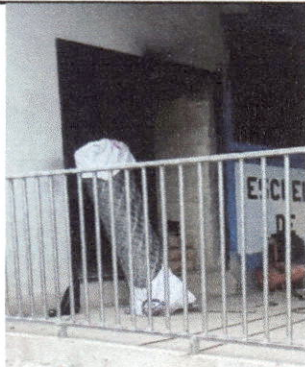
Foto 1: Mantenimiento a puertas de metal
