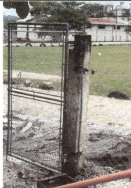
Foto 8: Sustitución de portón de metal
