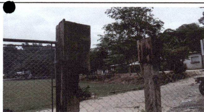
Foto 5: Reparación de tubo hg y malla galvanizada
