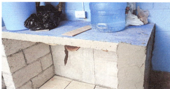
Foto 10: Instalación de azulejo en estufa rural
