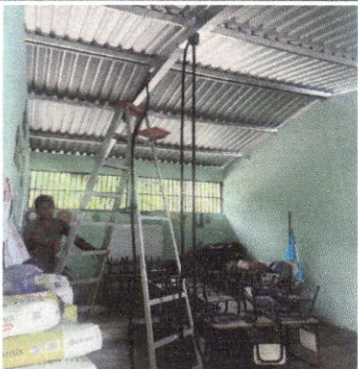
Foto 7: Sustitución de conducto eléctrico más accesorios
