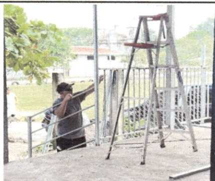
Foto 6: Fabricación e instalación de baranda de metal
