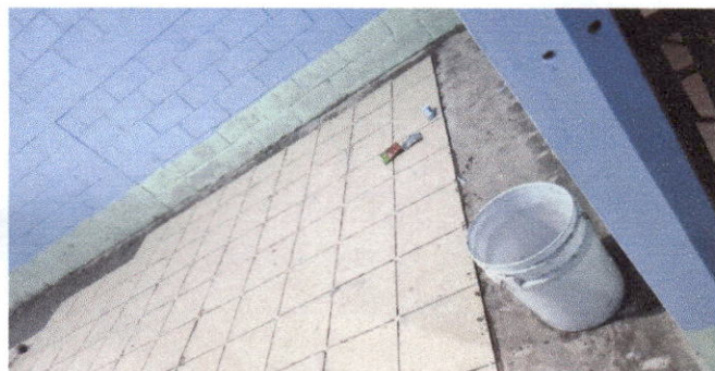
Foto 3: Sustitución de piso
