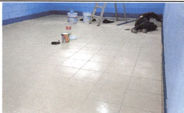
Foto 4: pintura en muros exteriores e interiores
