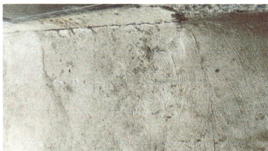
Foto 3: Sustitución de piso
