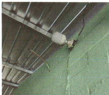
Foto 7: Sustrución de conducto electrico mas accesorios
