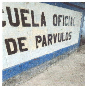
Foto 4: pintura en muros exteriores e interiores
