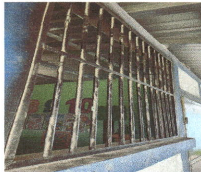
Foto 2: Mantenimiento a balcones de metal
