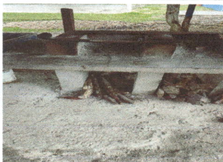
Foto 9: Sustrución de estufa rural
