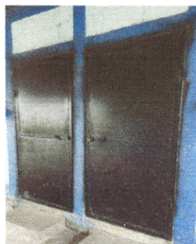
Foto 1: Mantenimiento a puertas de metal
