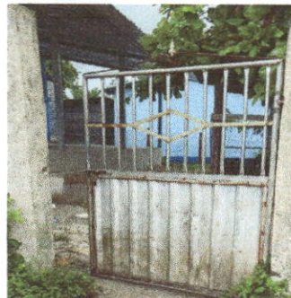
Foto 8: Sustrución de portón de metal
