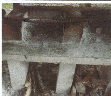
Foto 10: Instalación de azulejo en estufa rural
