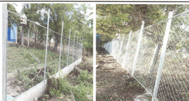
Foto 12: Mejoramiento instalación de tubo hg y malla galvanizada
