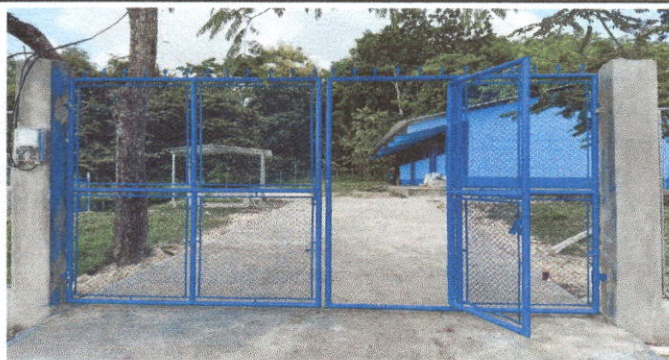
Foto 15: Mejoramiento y Fabricación e instalación de portón de metal de ingreso
