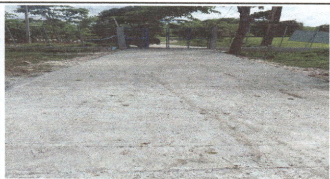
Foto 3: Sustitución de piso de torta de concreto
