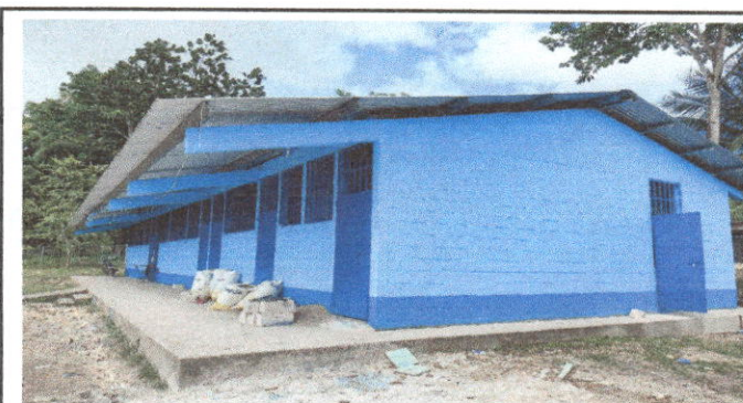
Foto 4: Pintura en muros exteriores e interiores
