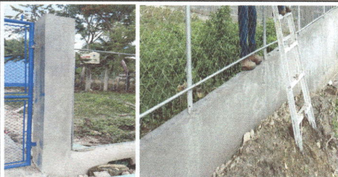
Foto 15: Aplicación de repello de muro de contención
