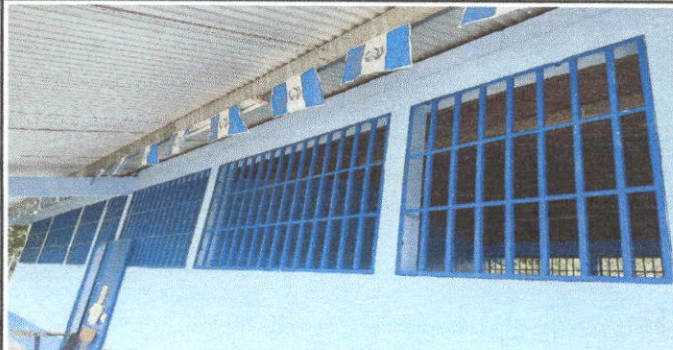
Foto 2: Mantenimiento aplicación de pintura a balcones de metal
