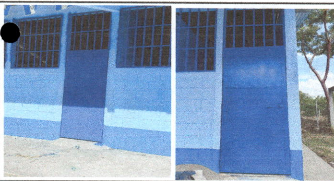
Foto 5: Mantenimiento a estructura (lijado, cepillado, aplicación de pintura) a puertas servicios sanitarios
