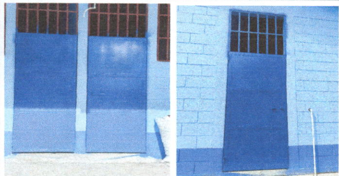
Foto 1: Mantenimiento a estructura (lijado, cepillado, sujeciones, aplicación de pintura) a puertas servicios sanitarios
