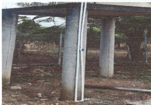
Foto 9: Sustitución de tubería línea principal
