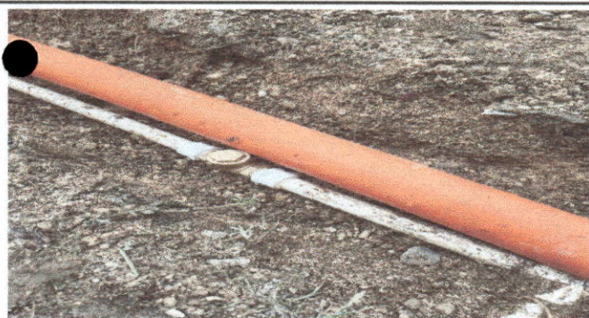
Foto 11: Sustitución de llave de cheque
