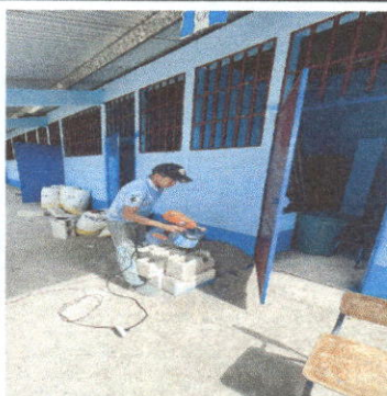
Foto 1: Mantenimiento a estructura (lijado, cepillado, sujeciones, aplicación de pintura) a puertas servicios sanitarios
