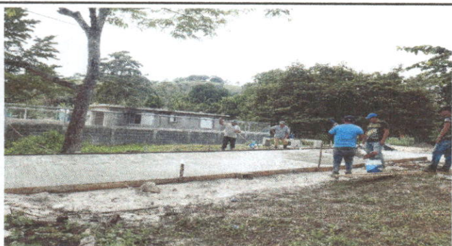
Foto 3: Sustitución de piso de torta de concreto
