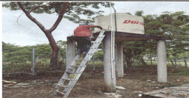
Foto 14: Instalación de deposito de agua 1700 lt
