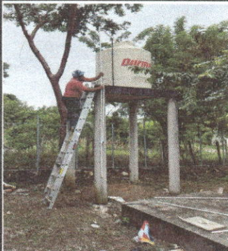
Foto 9: Sustitución de tubería línea principal
