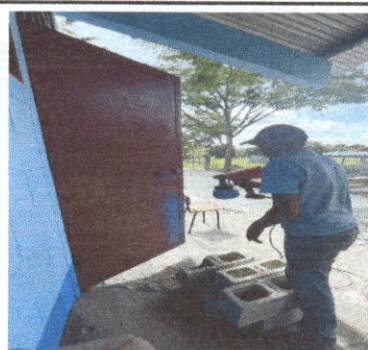
Foto 5: Mantenimiento a estructura (lijado, cepillado, aplicación de pintura) a puertas servicios sanitarios
