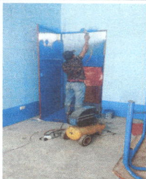
Foto 1: Mantenimiento a estructura (lijado, cepillado, sujeciones, aplicación de pintura) a puertas servicios sanitarios
