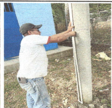
Foto 8: Sustitución de tubería PVC línea principal aguas negras (3 pulg)
