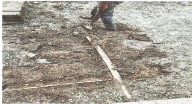
Foto 8: Sustitución de tubería PVC línea principal aguas negras (3 pulg)
