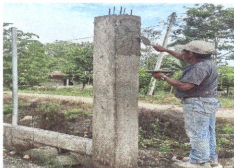
Foto 15: Aplicación de repello de muro de contención
