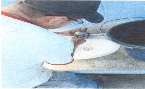
Foto 7: Sustitución de llave en mingitorio
