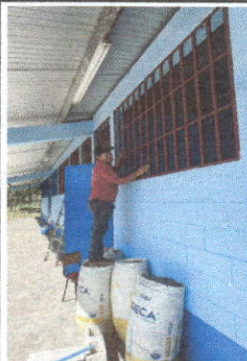
Foto 2: Mantenimiento aplicación de pintura a balcones de metal
