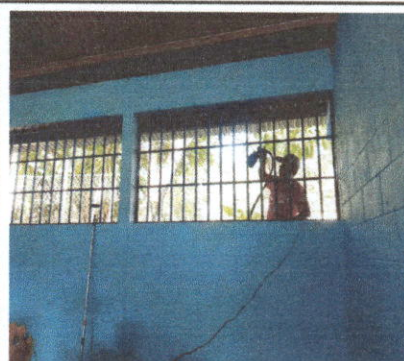
Foto 2: Mantenimiento aplicación de pintura a balcones de metal
