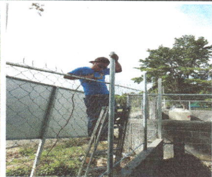
Foto 12: Mejoramiento instalación de tubo hg y malla galvanizada
