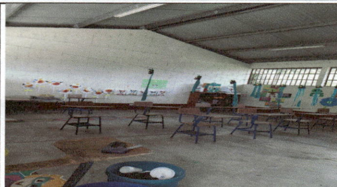
Foto 2 Pintura en muros exteriores e interiores
