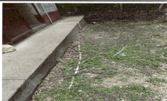
foto 6 Instalación de tubería para agua potable
