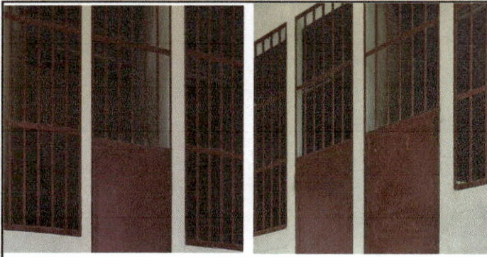
foto 12: Mantenimiento de balcones
