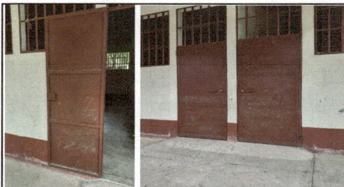
Foto 10 Mantenimiento a estructura (lijado, cambio de tubo, cepillado, sujeciones, aplicación de pintura)
