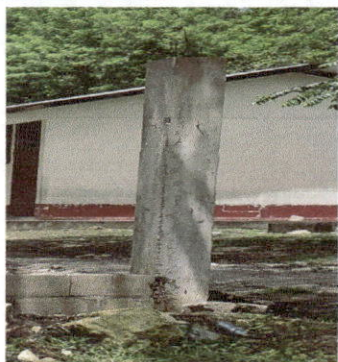
Foto 9 Aplicación de repello de muro de contención (columna)
