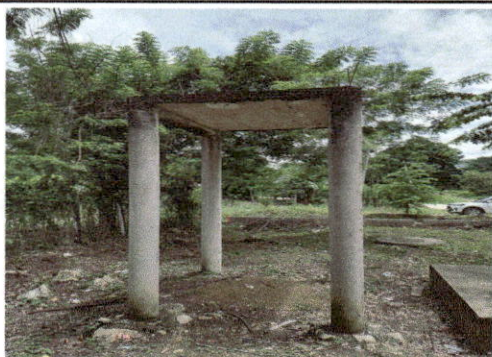
foto 5 Suministro de depósito de agua 1000 lt
