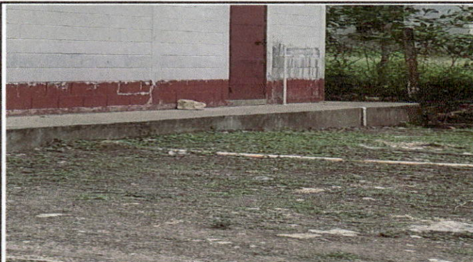
Foto 7 Sustrucción de tubería PVC línea principal aguas negras (3 pulg)
