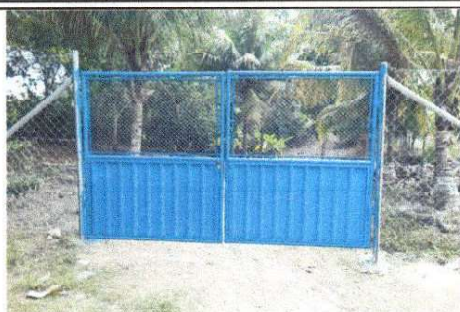
Foto 1: Sustrución de portón de metal
