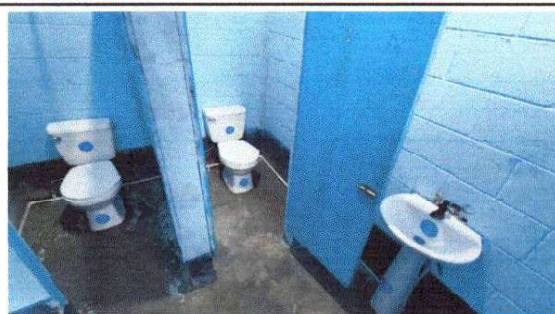
Foto 4: Sustrución de sanitario
