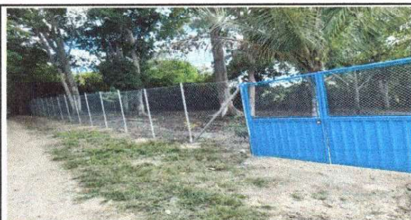
Foto 5: Reparacion de muro perimetral con malla y tubo hg
