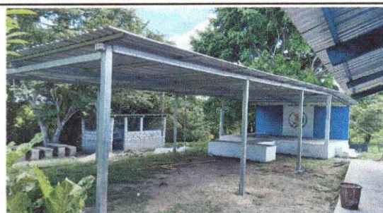
Foto 3: Sustrución de lamina por lamina troquelada
