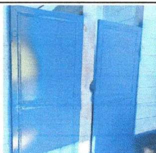
Foto 6: Sustrucion de puertas de baños
