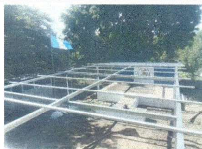
Foto 2: Sustrución de estructura de madera por metal
