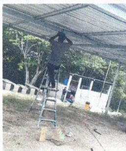
Foto 7: Sustitucion cableado eléctrico
