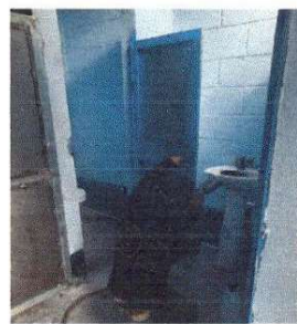
Foto 6: Sustitucion de puertas de baños
