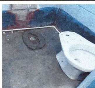
Foto 4: Sustitución de sanitario
