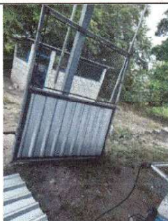
Foto 1: Sustitución de portón de metal
