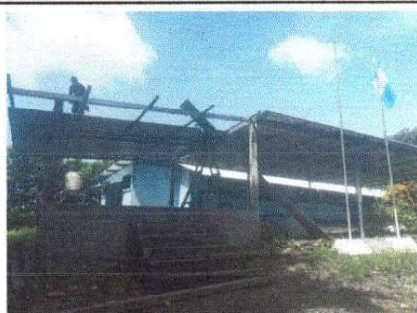
Foto 3: Sustitución de lamina por lamina troquelada
