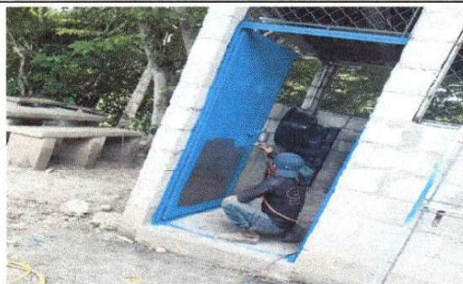
Foto 8: Sustitucion de puerta para la cocina
