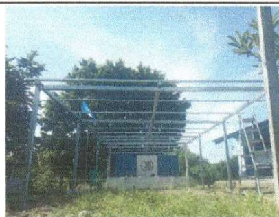
Foto 2: Sustitución de estructura de madera por metal
