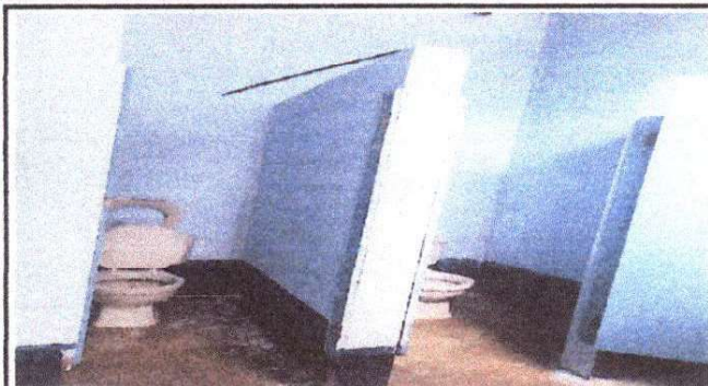
Foto 1: Sustrucion de puertas de baños
