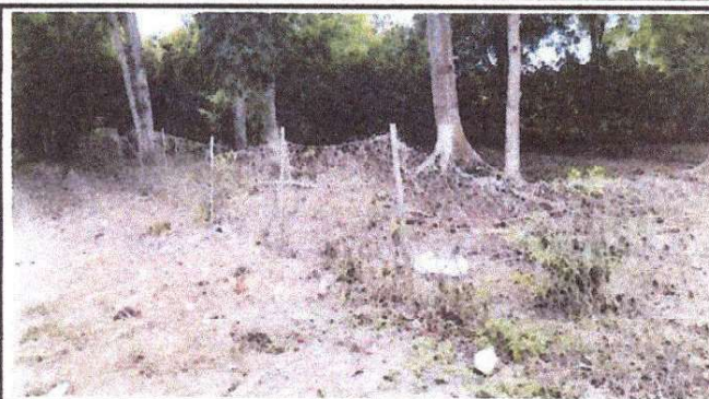
Foto 2: reparacion de muro perimetral con malla y tubo hg
