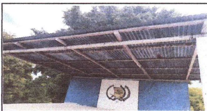
Foto 5: Sustrucion de estructura de madera por metal
