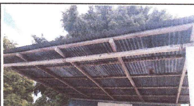
Foto 6: Sustrucion de lamina por lamina galvanizada
