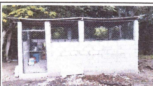
Foto 4: sustrucion de estructura de techo y lamina galvanizada
