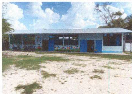
Foto 5: pintura de muros exteriores e interiores
