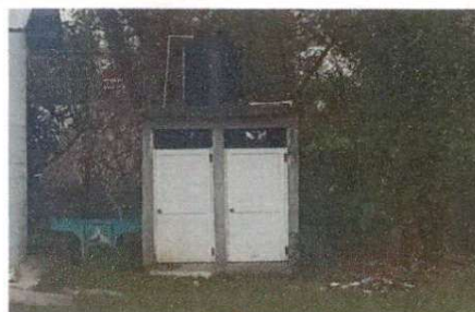
Foto 4: Instalacion de pila
