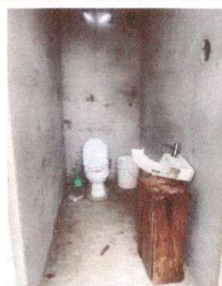
Foto 6: sustitucion de lavamanos
