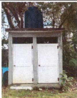
Foto 3: Sustitucion de deposito de agua 1700 Lt.
