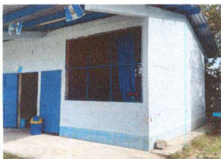
Foto 3: Sustitución de balcones
