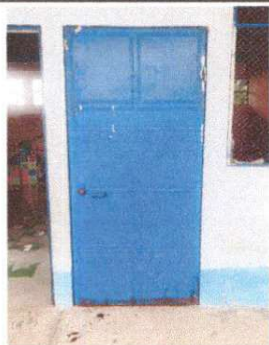
Foto1: Sustición de puerta
