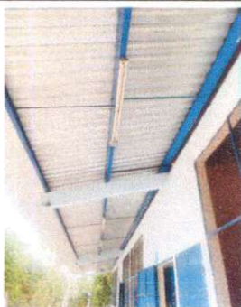
Foto1: Sustitucion de lamparas tipo led
