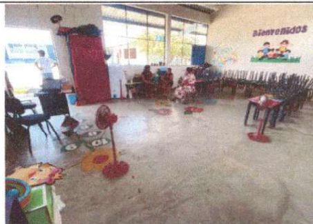
Foto 4: Reparación de piso de cemento
