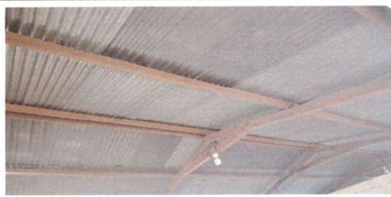
Foto 2: Mantenimiento a estructura de soporte de metal
