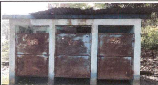
Foto 5: Mantenimiento a estructura (lijado, cambio de tubo , cepillado, sujeciones, aplicación de pintura) a puertas sanitarios
