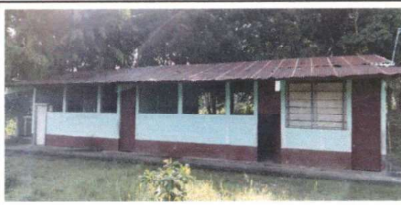
Foto 6: Pintura en muros exteriores e interiores
