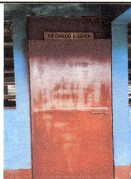
Foto: 4 MANTENIMIENTO DE ESTRUCTURA DE LAS PUERTAS
