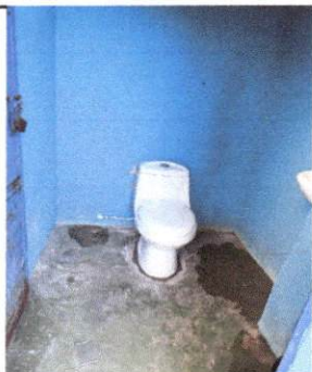
Foto: 5 SUSTITUCIÓN DE INODORO
