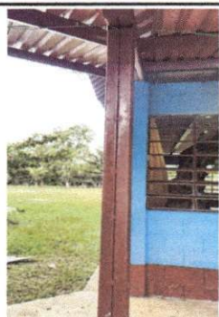
Foto: 3 SUSTITUCIÓN DE ESTRUCTURA PORTANTE DE METAL
