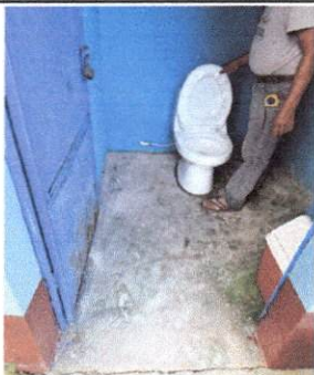
Foto 5: SUSTITUCIÓN DE INODORO
