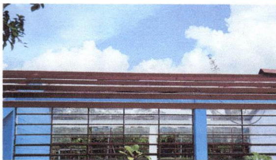
Foto 2: MANTENIMIENTO DE ESTRUCTURA
