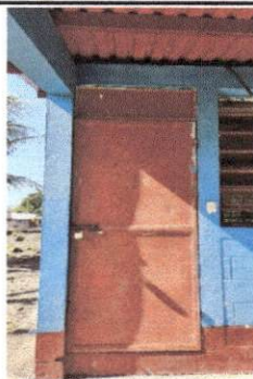
Foto 4: MANTENIMIENTO DE ESTRUCTURA DE LAS PUERTAS
