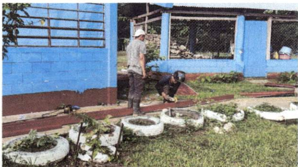
Foto 3: SUSTITUCIÓN DE ESTRUCTURA PORTANTE DE METAL
