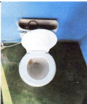
Foto 5: SUSTITUCIÓN DE INODORO
