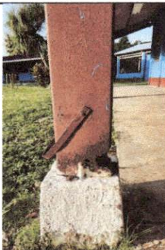
Foto 3: SUSTITUCIÓN DE ESTRUCTURA PORTANTE DE METAL
