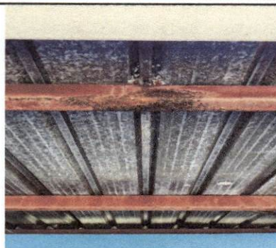
Foto 2: MANTENIMIENTO DE ESTRUCTURA
