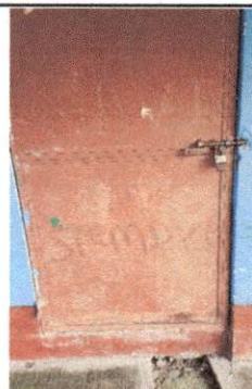
Foto 4: MANTENIMIENTO DE ESTRUCTURA DE LAS PUERTAS
