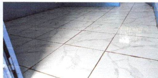
Foto 2: Mejoramiento de piso liso por piso porcelánico
