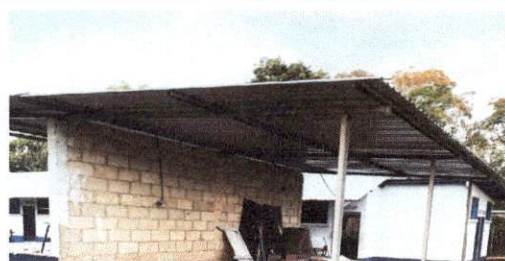
Foto 4: CUBIERTA DE LAMINA DE ESTRUCTURA Y LAMINA
