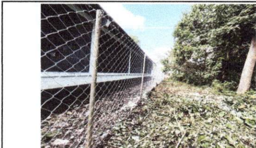
Foto 1: Reparación de muro perimetral con tubo hg y malla galvanizada
