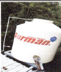
Foto 3: Sustitución de deposito de agua 1700 lt
