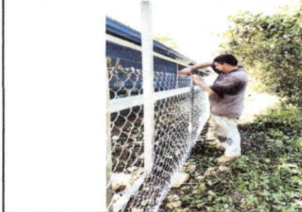
Foto 1: Reparación de muro perimetral con tubo hg y malla galvanizada
