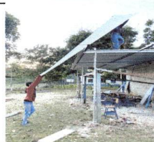
Foto 4: CUBIERTA DE LAMINA DE ESTRUCTURA Y LAMINA
