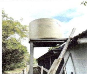
Foto 3: Sustitución de deposito de agua 1700 lt
