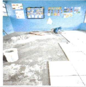
Foto 2: Mejoramiento de piso liso por piso porcelánico
