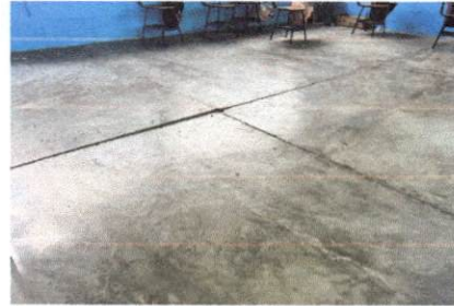
Foto 2: Mejoramiento de piso liso por piso porcelánico
