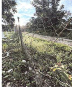
Foto 1: Reparación de muro perimetral con tubo hg y malla galvanizada
