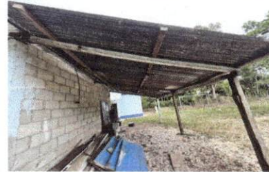
Foto 4: CUBIERTA DE LAMINA DE ESTRUCTURA Y LAMINA
