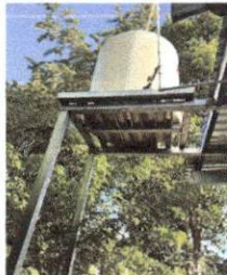
Foto 3: Sustitución de deposito de agua 1700 lt
