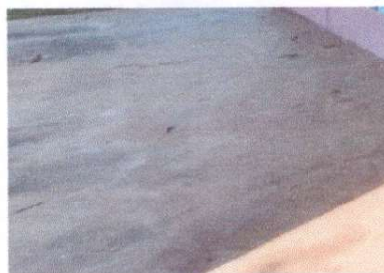
Sustitución de piso de torta de concreto
