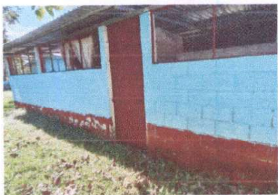
Pintura en muros exteriores e interiores
