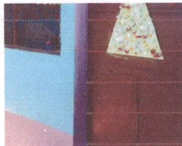
Sustitución de chapa
