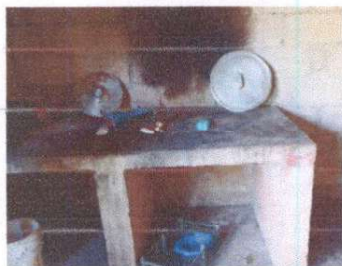
Instalación de azulejo en estufa rural
