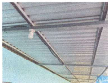
Reparación de cableado eléctrico
