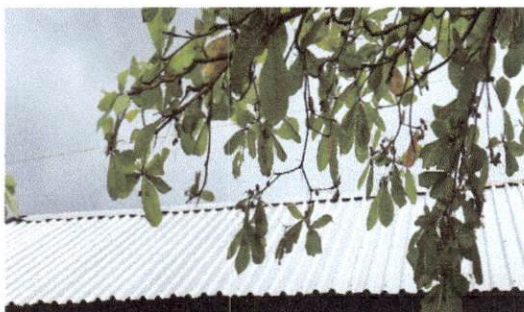
Foto 1: SUSTITUCIÓN DE LÁMINA, POR LÁMINA TROQUELADA FINALIZADO
