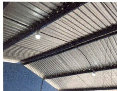
Foto: 2 SUSTITUCIÓN DE SISTEMA ELECTRICO, BOMBILLAS, PLAFONERAS, CABLES Y COLOCAR DUCTO YA REALIZADO
