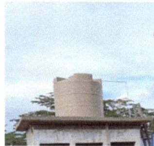
Foto: 4 SUSTITUCIÓN DE DEPOSITO DE AGUA DE 1700 LT YA INSTALADO
