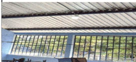
Foto: 4 MANTENIMIENTO DE BALCONES FINALIZADO Y TAMBIEN SE AGREGARÁ UNAS PLANAS PARA DEJAR LOS ESPACIOS MAS PEQUEÑOS
