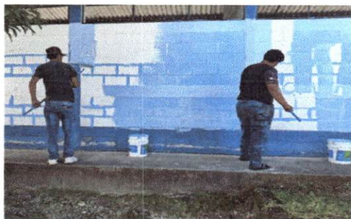
Foto 5: PINTANDO LOS MUROS EXTERIOR E INTERIOR
