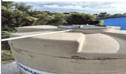
Foto: 4 INSTALANDO DEPOSITO DE AGUA DE 1700 LT
