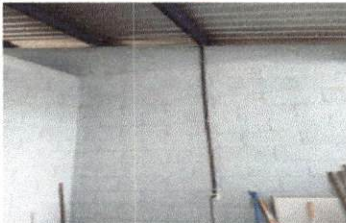
Foto: 3 COLOCACION DE TOMACORRIENTES DOBLES XON DUCTO INCLUIDO
