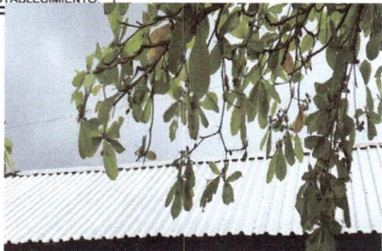
Foto 1: SUSTITUCIÓN DE LÁMINA, POR LÁMINA TROQUELADA
