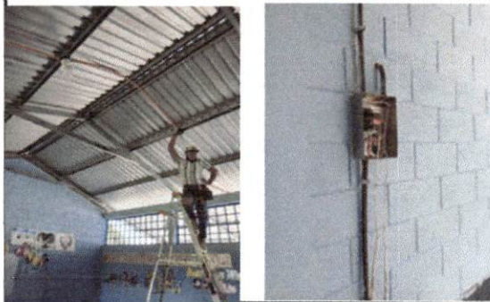
Foto 2 TRABAJANDO EL SISTEMA ELECTRICO, BOMBILLAS, PLAFONERAS, CABLES Y COLOCAR DUCTO
