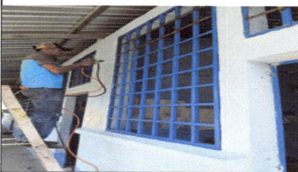
Foto 4: PINTANDO LOS BALCONES Y LAS PLANAS
