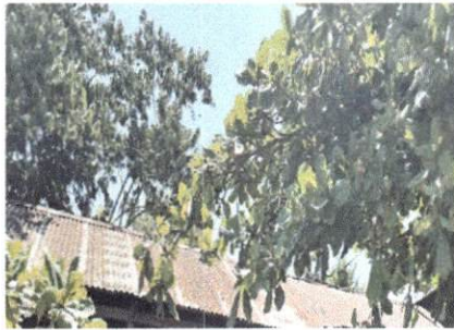
Foto 1: SUSTITUCIÓN DE LÁMINA, POR LÁMINA TROQUELADA
