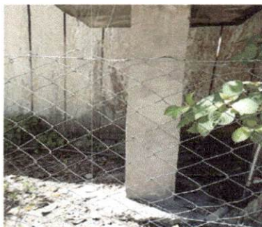
Foto 1: SUSTITUCIÓN DE MURO DE CONCRETO Y TERRAZA DE 2X3
