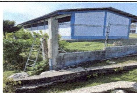
Foto 6: REPARACIÓN DE MURO PERIMETRAL
