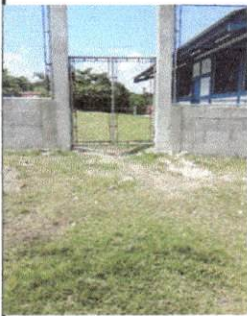
Foto 3: SUSTITUCIÓN DE DOS PORTONES
