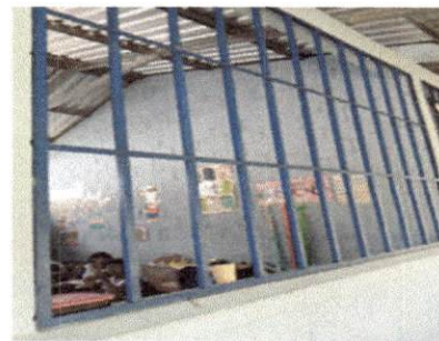
Foto 4: MANTENIMIENTO DE BALCONES Y TAMBIEN SE AGREGARÁ UNAS PLANAS PARA DEJAR LOS ESPACIOS MAS PEQUEÑOS
