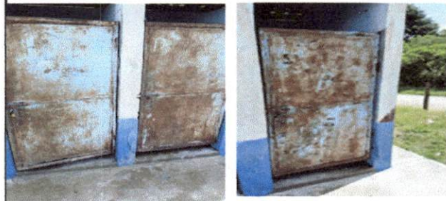
Foto 2: SUSTITUCIÓN DE TRES PUERTAS DE LOS BAÑOS
