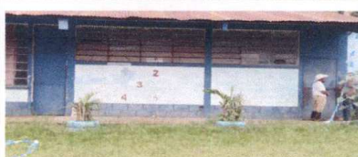
Foto 4: Pintura en muros exteriores e interiores
