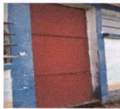
Foto 6: Sustrucción de puerta
