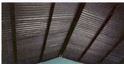
Foto 3: Sustrucción de estructura de soporte de metal
