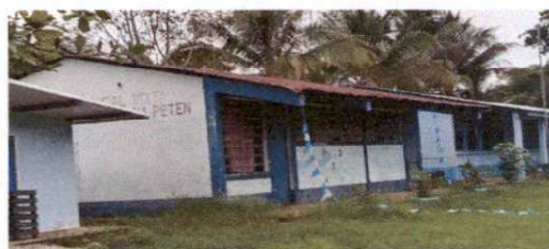
Foto 2: Mantenimiento a estructura de soporte de metal
