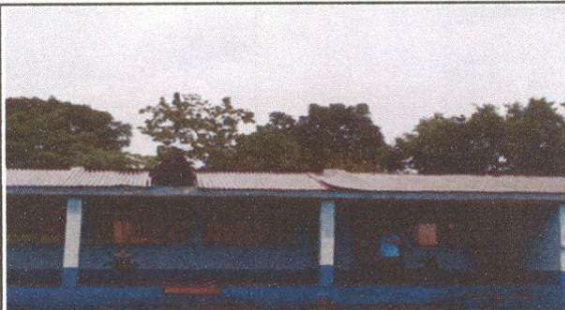
Sustitucion de lamina por lamina
