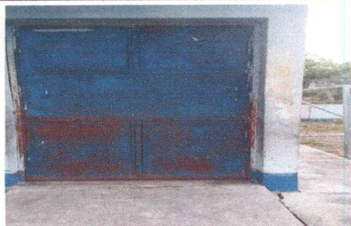
Fabricacion e Instalacion Puertas
