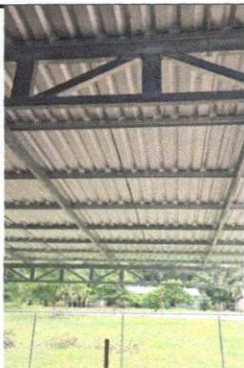
Foto 3: Sustitución de estructura de soporte de metal por metal
