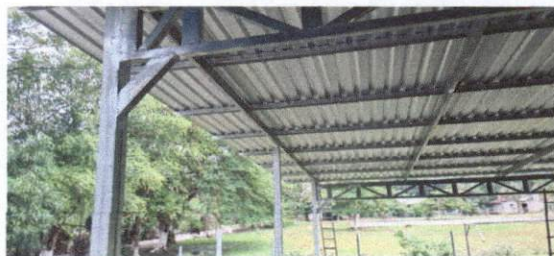
Foto 4: Sustitucion de estructura de soporte metalica por metal
