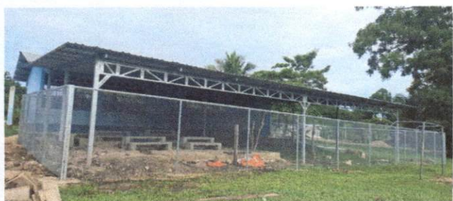
Foto 5: Reparacion de tubo GH y malla galvanizada
