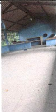
Foto 1: sustitucion de piso ceramico
