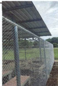
Foto 6: reparacion de tubo gh y malla galvanizada
