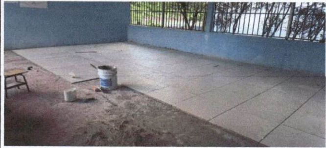
Foto 2: Sustitución De piso ceramico
