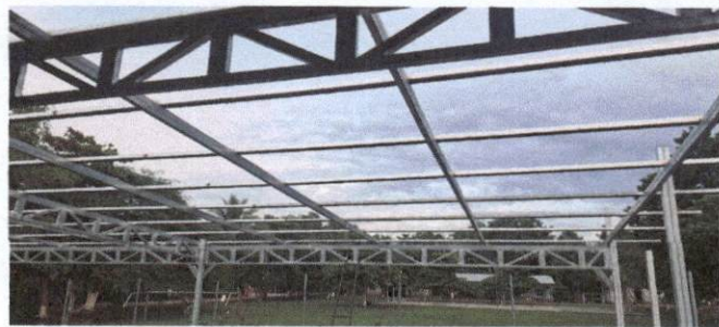
Foto 4: Sustitucion de estructura de soporte metalica por metal
