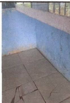
Foto 4: sustitucion de piso ceramico
