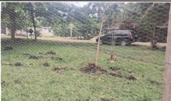
Foto 6: Reparacion de tubo GH y malla galvanizada
