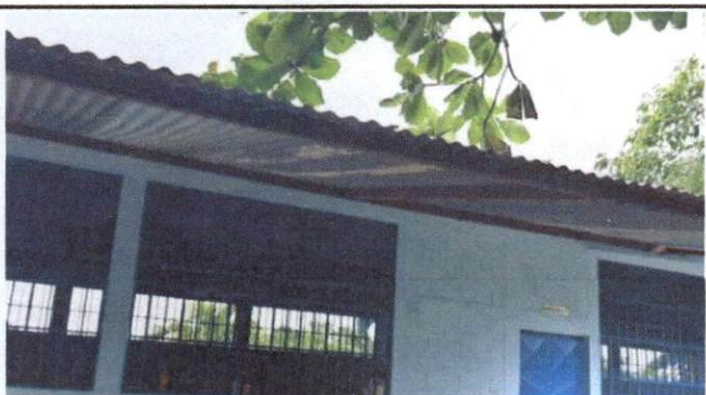
Foto 3: Sustrucción de lamina, por lamina troquelada
