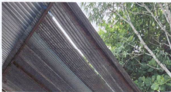
Foto 2: Sustrucción de estructura de soporte de metal
