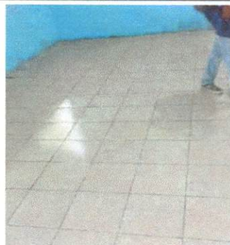
Foto 8: sustuticion de piso ceramico
