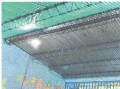
Foto 3: sustitucion de lamparas tipo led
