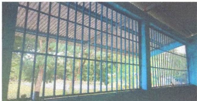
Foto 1: sustitucion de de metal de venan en una aula
