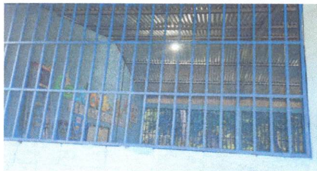
Foto 2: sustitucion de balcones de metal en 3 aulas
