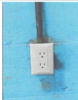
Foto 6: sustitucion de tomacorrientes dobles
