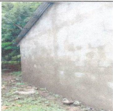
Foto 7: reparacion de repello y cernido en paredes
