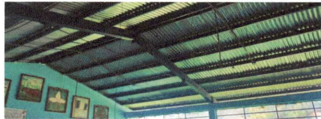
Foto 4: sustitucion de plafoneras
