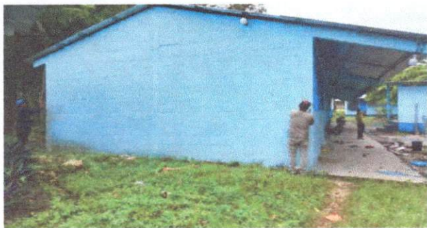
Foto 7: reparacion de repello y cernido en paredes
