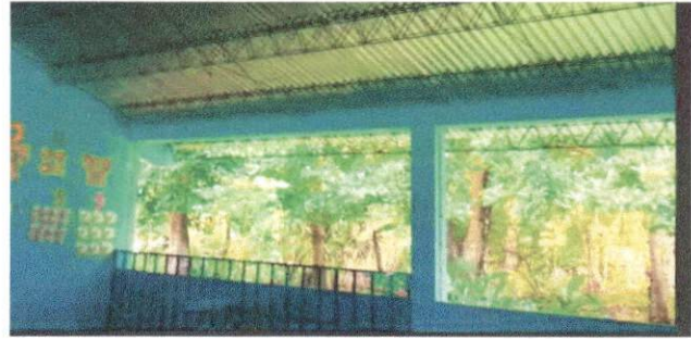
Foto 2: sustitucion de balcones de metal en 3 aulas
