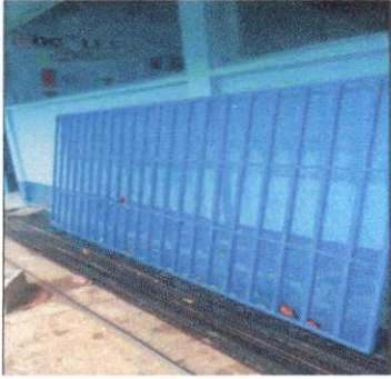
Foto 1: sustitucion de de metal de venan en una aula
