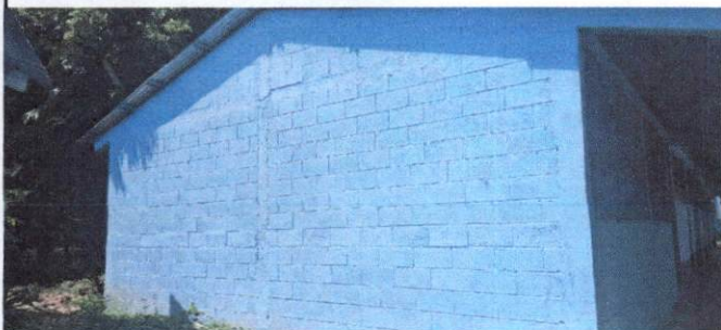
Foto 7: Reparación de repello y cernido de paredes (cuando aplique)
