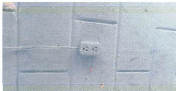
Foto 6: Sustitución de tomacorrientes dobles
