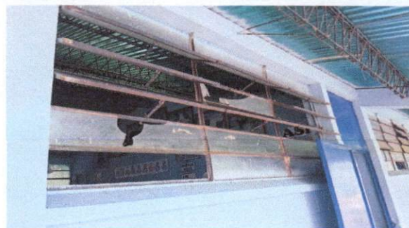
Foto 2: Sustitución de balcones de metal en 3 aulas
