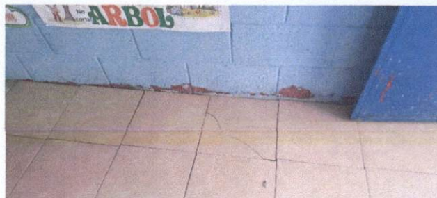
Foto 8: Sustitución de piso cerámico
