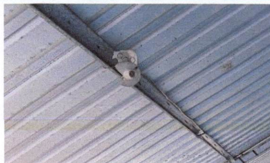
Foto4: Sustitución de plafoneras
