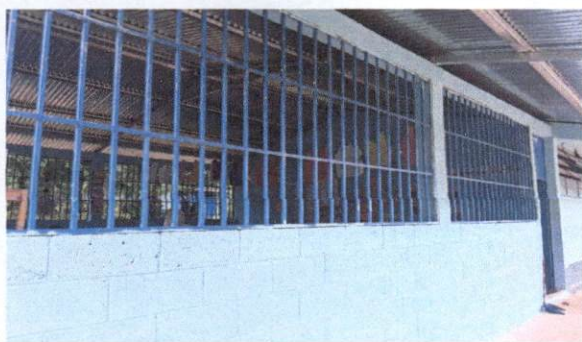
Foto 1: Sustitución de metal de ventana en una aula
