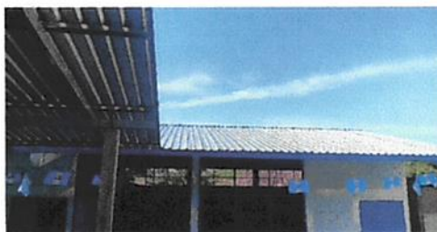
Foto: cambio de techo de lamina en dos aulas nuevas
