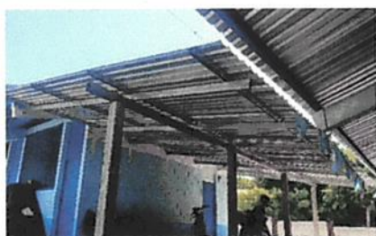
Foto: con techo de nuevo
