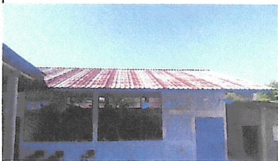
Foto 1: CAMBIO DE TECHO
