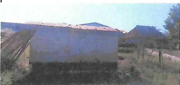
Foto 5: CAMBIAR TECHO DE BAÑOS
