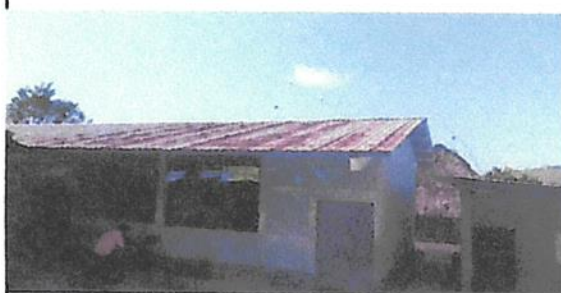
Foto 2: PINTURA EN MUROS EXTERIOR E INTERIORES
