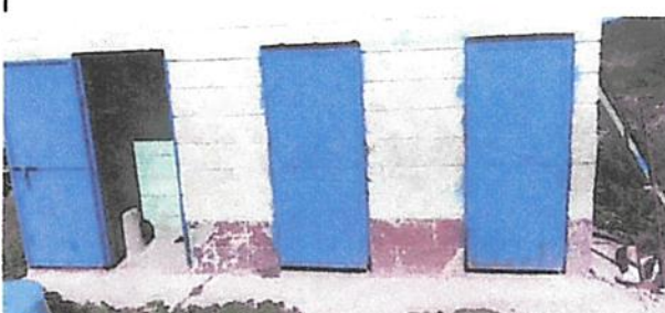
Foto 6: PINTURA EN MUROS DE BAÑOS EXTERIORES E INTERIORES
