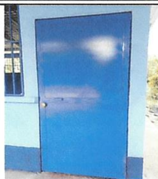
Foto 2 SUSTITUCION DE PUERTA
