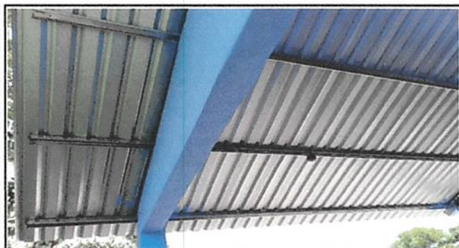
Foto 3 SUSTITUCION DE ESTRUCTURA DE TECHO
