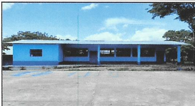
Foto 1: SUSTITUCION DE LAMINA POR LAMINA
