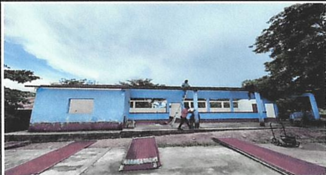
Foto 1: SUSTITUCION DE LAMINA POR LAMINA
