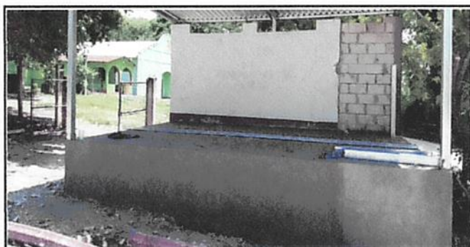
Foto: 5 SUSTITUCION DE TORTA DE PISO DE CONCRETO
