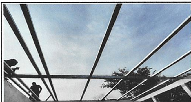
Foto: 3 SUSTITUCION DE ESTRUCTURA DE TECHO
