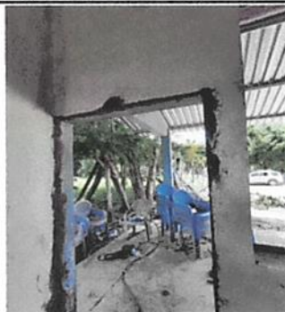
Foto 2 SUSTITUCION DE PUERTA
