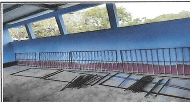
Foto: 4 SUSTITUCION DE VENTANAS DE MADERA POR METAL
