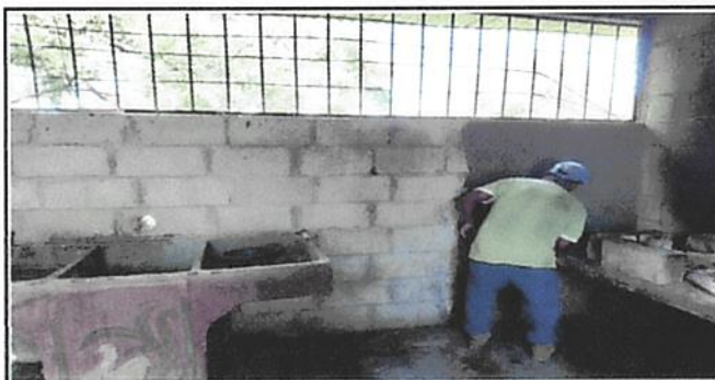
Foto: 6 REPELLO DE MUROS Y PAREDES
