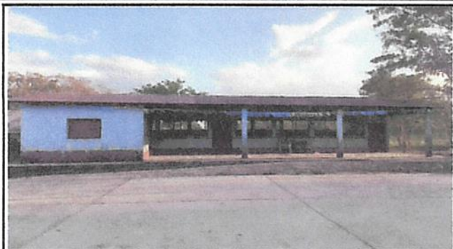
Foto 1: SUSTITUCION DE LAMINA POR LAMINA
