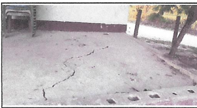
Foto: 5 SUSTITUCION DE TORTA DE PISO DE CONCRETO
