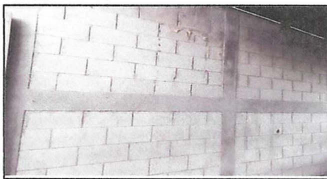
Foto: 6 REPELO DE MUROS Y PAREDES
