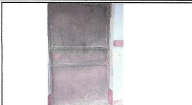
Foto 2 SUSTITUCION DE PUERTA
