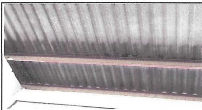
Foto: 3 SUSTITUCION DE ESTRUCTURA DE TECHO
