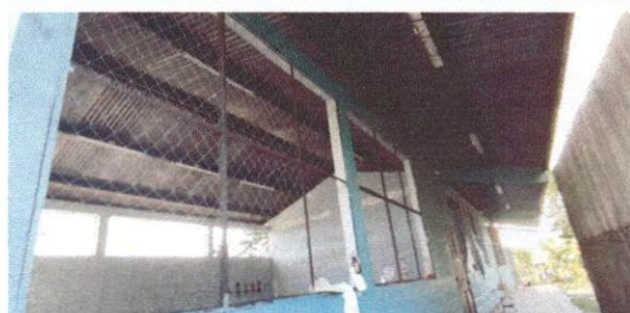
Foto 6: Sustitución de balcones de metal
