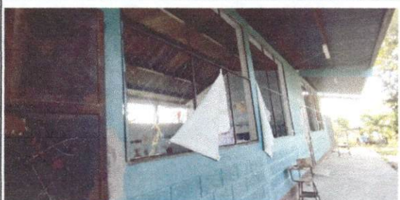
Foto Pintura en muros exteriores e interiores:
