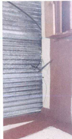
17.11 Reparación de cableado eléctrico
