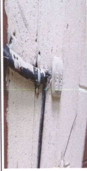
17.8 Sustitución de tomacorrientes dobles
