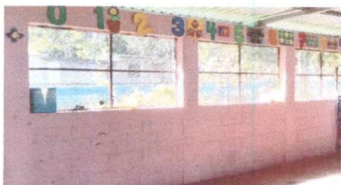
Mantenimiento a estructura de metal de ventana
