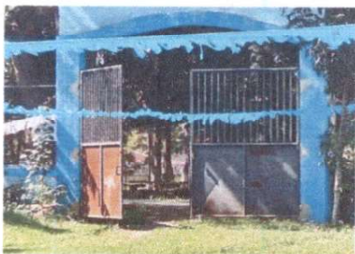
Mantenimiento a portones de metal
