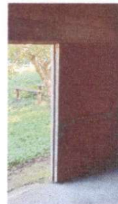
Sustitución de puerta
