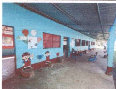
Pintura en muros exteriores e interiores
