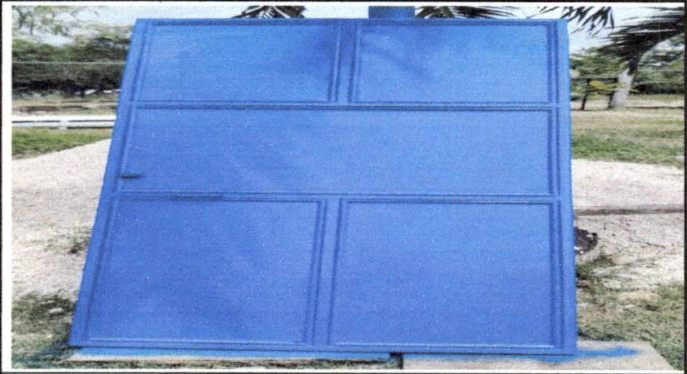
Foto 2: 4.1 Mantenimiento a estructura (lijado, cambio de tubo, cepillado, sujeciones, aplicación de pintura)
