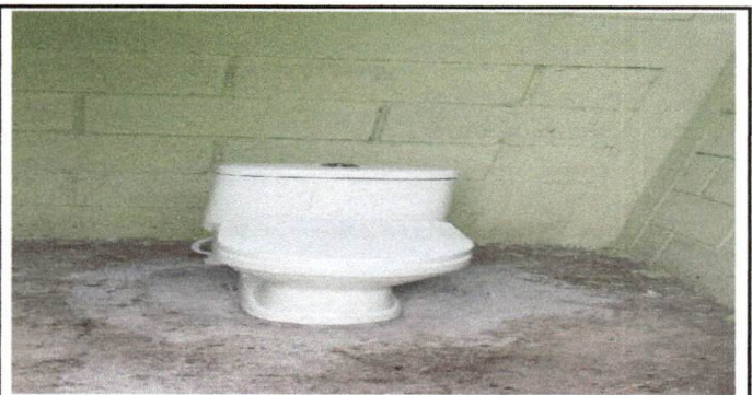
Foto 6: 10.3 Sustitución de inodoro
