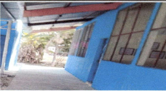
Foto 3: 9.1 Pintura en muros exteriores e interiores
