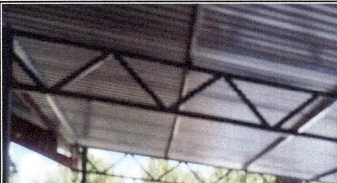
Foto 4: 1.1 Sustitución de lámina por lámina troquelada aluzinc. 1.3 Sustitución de elementos de fijación. 2.2 sustitución de estructura de soporte de madera por metal.
