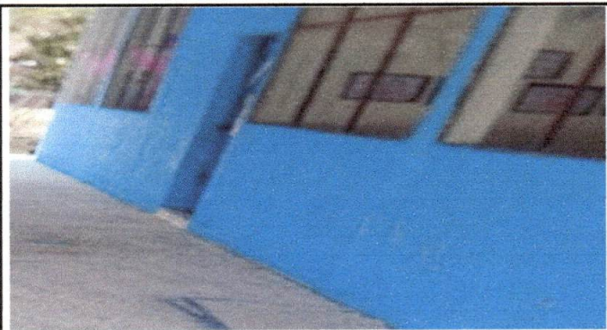
Foto 3: 9.1 Pintura en muros exteriores e interiores
