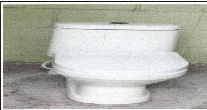
Foto 6: 10.3 Sustitución de inodoro
