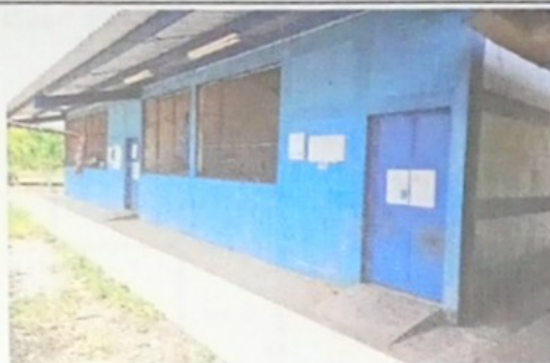
Foto 4: Pintura en muros exteriores e interiores
