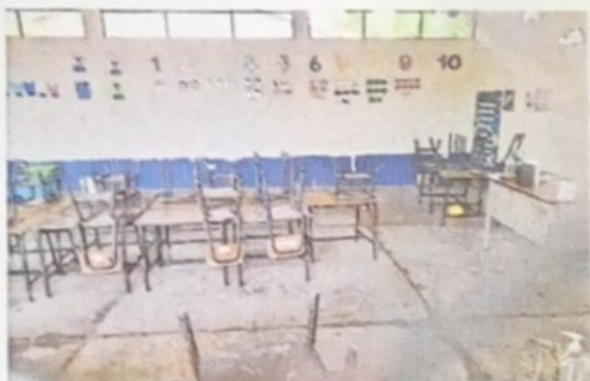
Foto 3: Reparación de piso de torta de concreto
