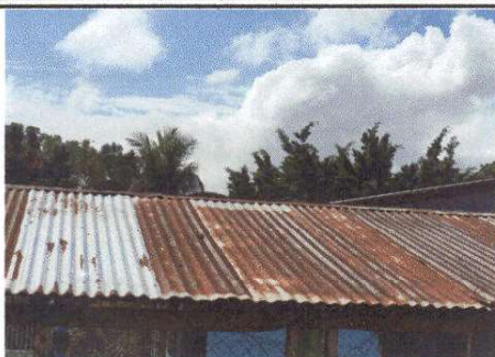
CUBIERTA DE LAMINA
