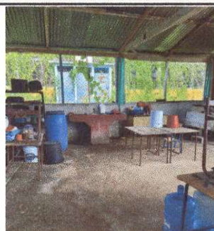
ESTRUCTURA DE TECHO
