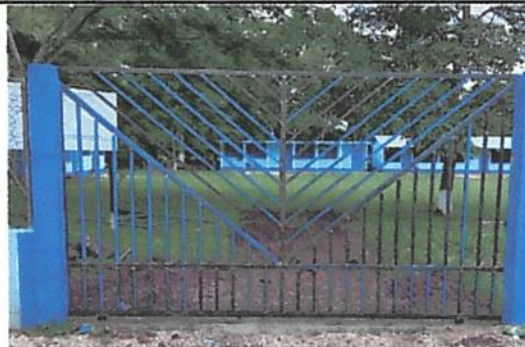
Foto 2: Fabricación en instalación de portón de metal de ingreso.
