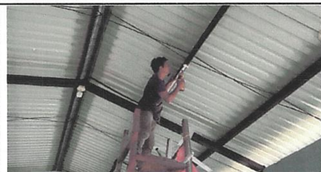
Foto 5: Sustitución de lámparas LED.
