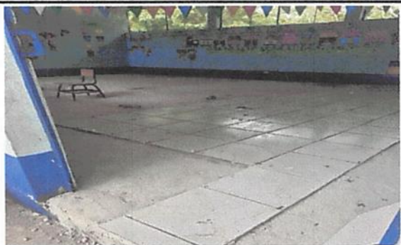
Foto1: Sustitución de piso cerámico.
