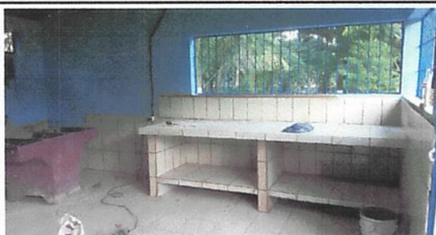
Foto 3: Reparación de azulejo en mueble de cocina.
