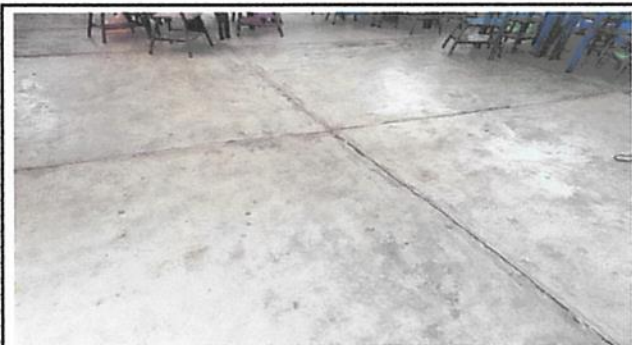
Foto 1: Sustrucción de piso en aula.
