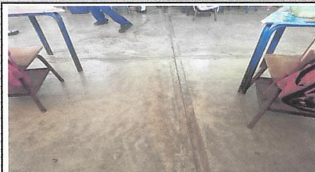
Foto 3: Sustrucción de piso en aula.
