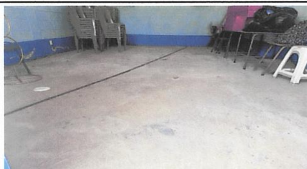
Foto 2: Sustrucción de piso.
