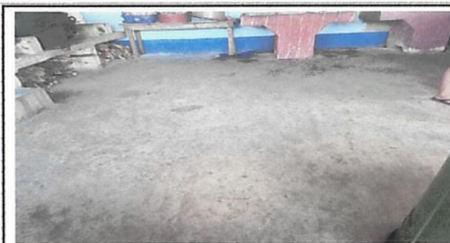
Foto 5: Piso área de cocina
