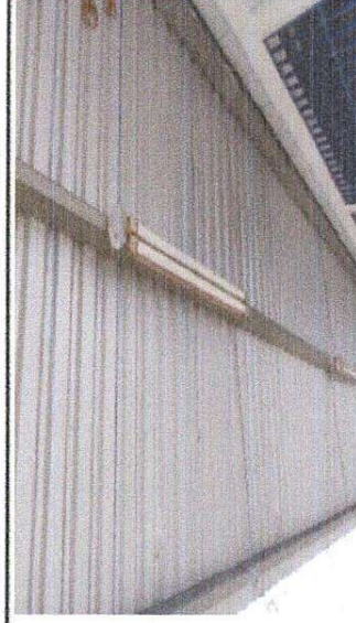
Foto 6: Reparación de cableado eléctrico
