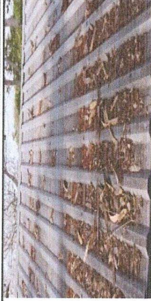
Foto 1: Sustrucción de lámina, por lámina troquelada aluzinc calibre 26
