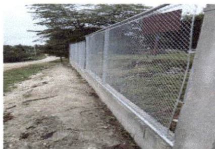
Foto 6: trabajo finalizado de Reparación de muro perimetral de block con tubo hg y malla galvanizada, soleras intermedias y columnas
