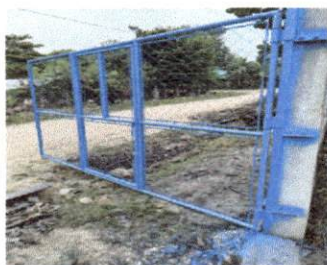
Foto 5: Mantenimiento de porton terminado
