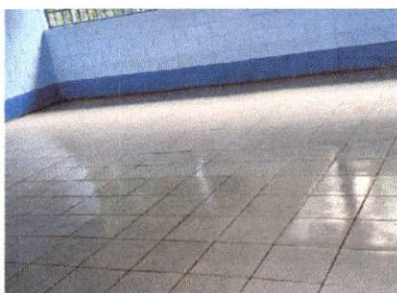
Foto 3: Sustitución de piso de cemento liquido por piso ceramico terminado
