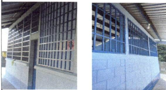
Foto 2: Mantenimiento de balcones terminado
