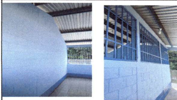
Foto 4: Pintura en muros exteriores e interior finalizado
