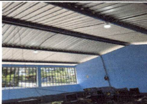
Foto: 4 Pintura en muros exteriores e interior asi va quedando
