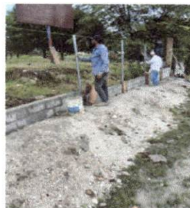
Foto: 6 Reparación de muro perimetral de block con tubo hg y malla galvanizada, soleras intermedias y columnas ya iniciado
