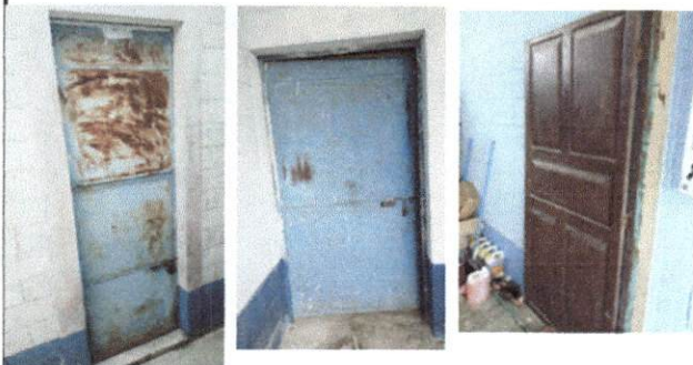
Foto 1: Sustitución de Puerta de metal en elaboracion
