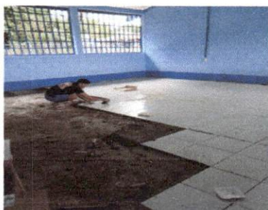
Foto 3 Sustitución de piso de cemento liquido por piso ceramico ya en trabajo
