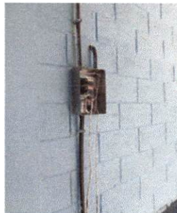
Foto: 8 Sustitución de caja de flpones, cableado electrico y sus accesorios
