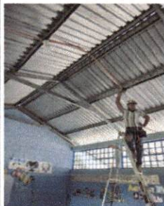
Foto 7 : Sustitución de focos ahorradores, plafoneras y tomacorrientes dobles ya en proceso
