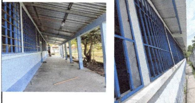
Foto 2: Mantenimiento de balcones ya en preparación
