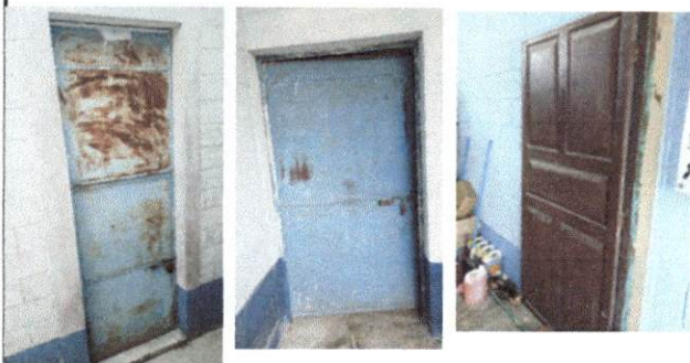
Foto 1: Sustitución de Puerta de metal
