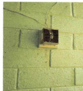
Foto: 8 Sustrucción de caja de flipones, cableado electrico y sus accesorios
