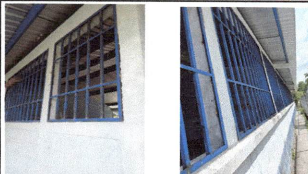
Foto 2: Mantenimiento de balcones
