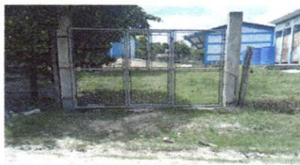
Foto 5: Mantenimiento de porton
