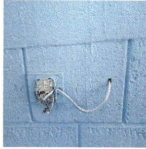
Foto 7 : Sustrucción de focos ahorradores, plafoneras y tomacorrientes dobles
